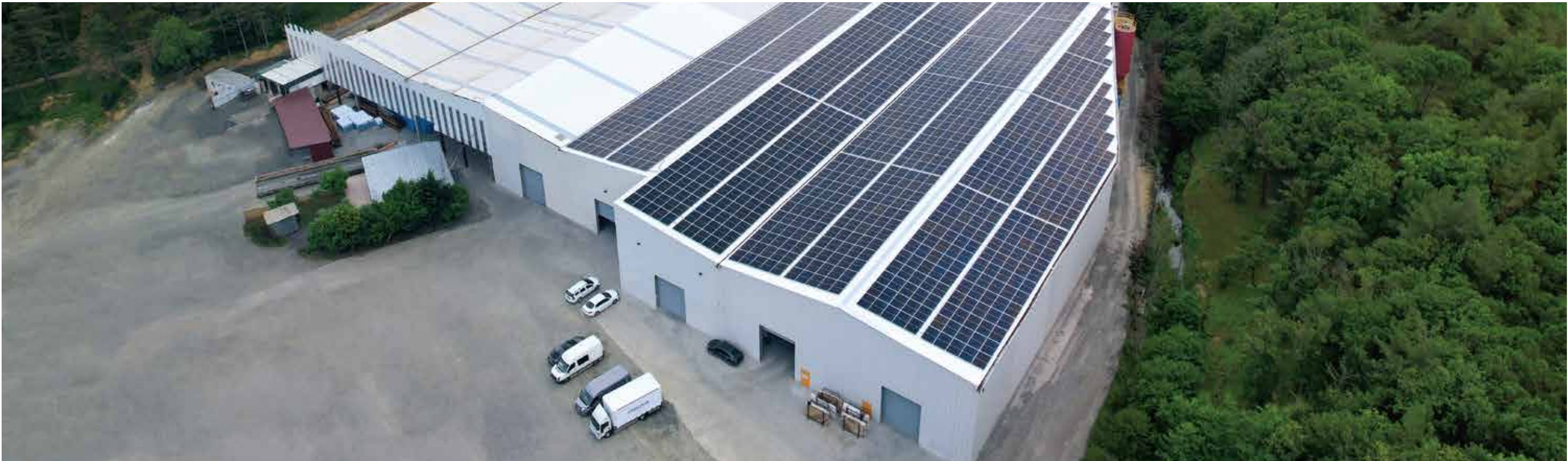
09 Riduzione dei costi energetici per uno stabilimento di Turchia, 900 kW KSG-120CL-M0
